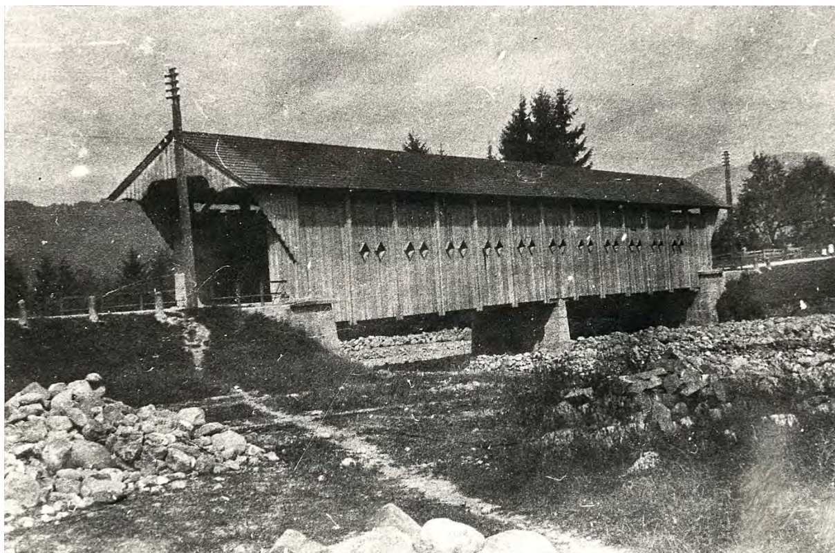
Abbildung 9: Holzbrücke Brünigstrasse über grosse Schliere vor 1931. Quelle: Foto, Sammlung Otto Camenzind.
