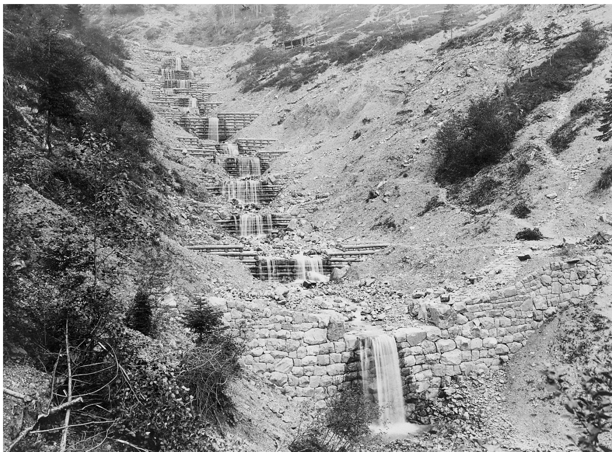
Abbildung 19: Steinsperre und Holzsperrern im Rotmoosgraben nach Erstellung um ca. 1905. Quelle: Foto, Amt für Wald und Landschaft des Kantons Obwalden.
