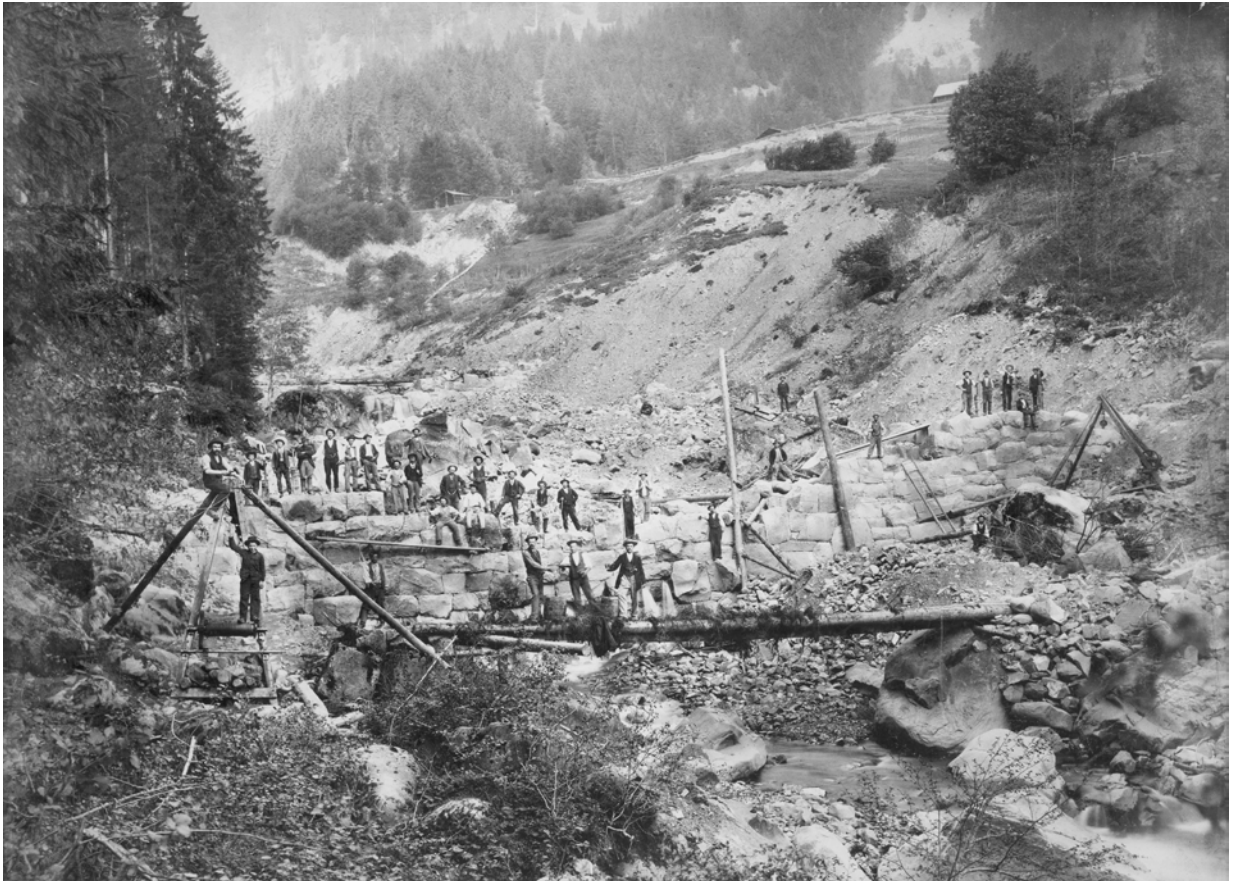
Grosse Schiere, Gehretschwand im Jahr 1897. Arbeiter bei der Erstellung einer Wildbachsperre. Quelle: Amt für Wald und Landschaft des Kantons Obwalden.
