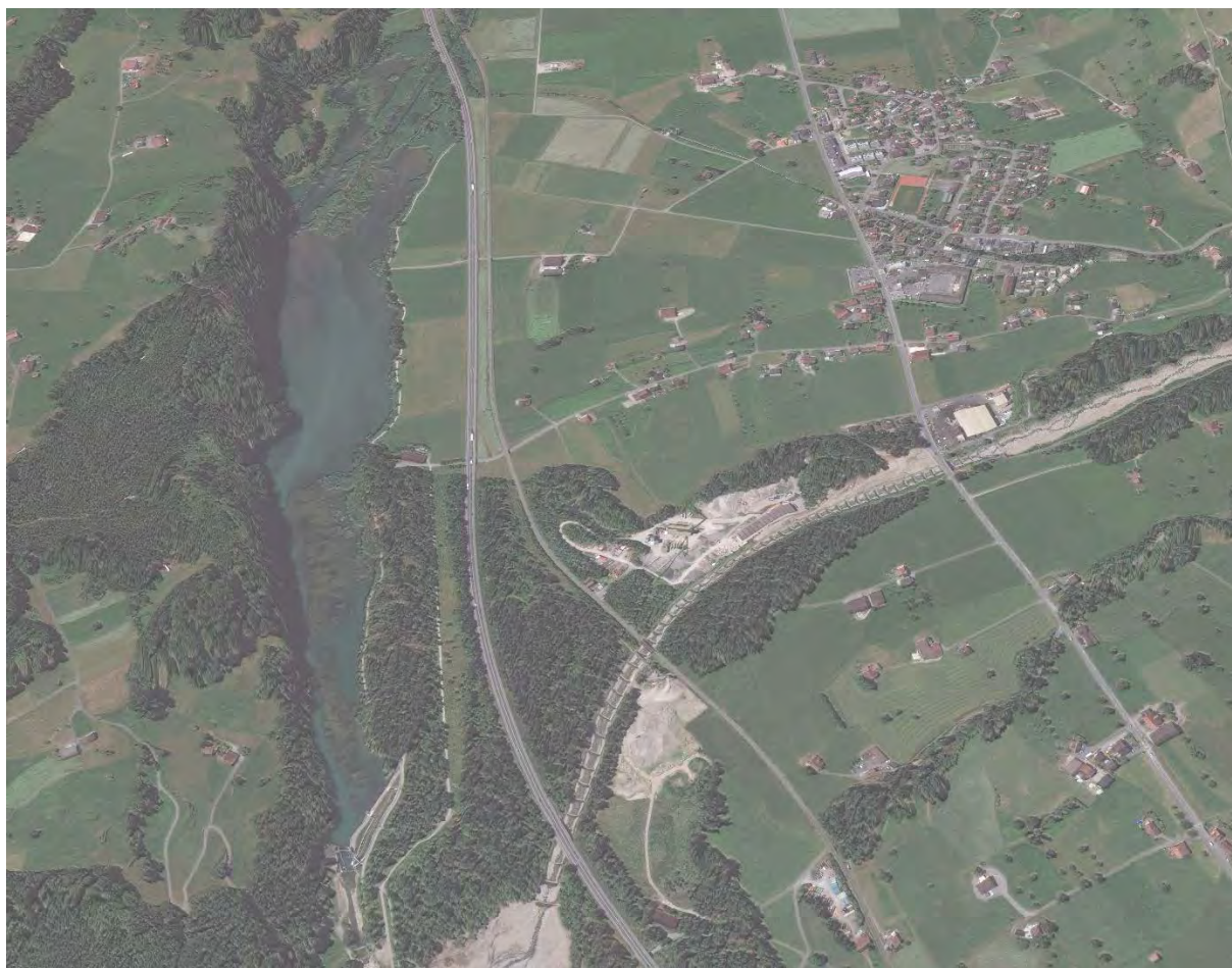
Abbildung 8: Grosse Schliere im Schwemmkegel kanalisiert und einem Geschiebesammler im Jahr 2012. Quelle: Orthophotoplan 2012, GIS Daten AG.
