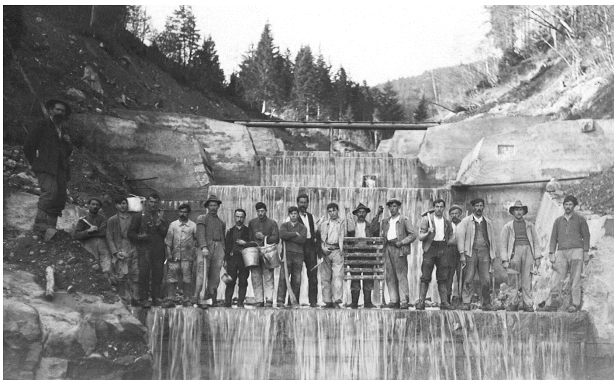
Abbildung 20: Betonsperren Mettenlauri um ca. 1938. Quelle: Foto, Amt für Wald und Landschaft des Kantons Obwalden.
